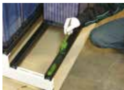
5-12 : Positionnement des rails d'installation
