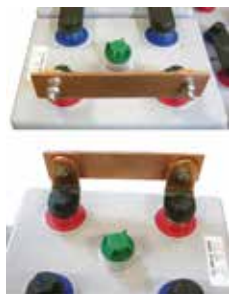
Abb. 5-18: 2 Montage der Endpole (Anschlussplatten)
