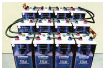
Fig. 5-16: utilisation de connecteurs en ligne et pour gradins
