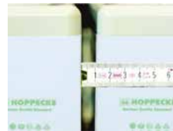
Abb. 5-14: 10 mm Abstand zwischen den Batteriezellen
