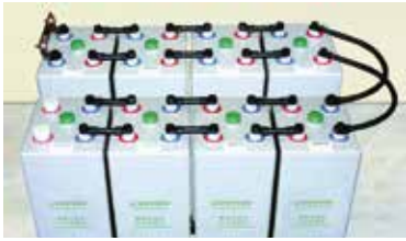
Abb. 5-15: Einsatz von Reihenverbindern und Stufenverbindern
